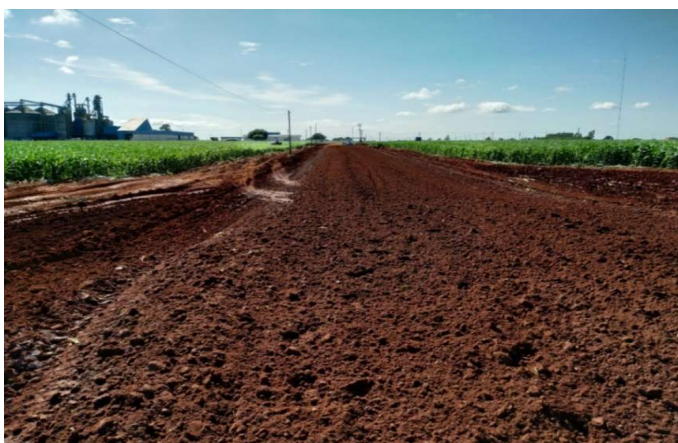
Figura 9 - Verificação da umidade do solo “ideal” para compactação
