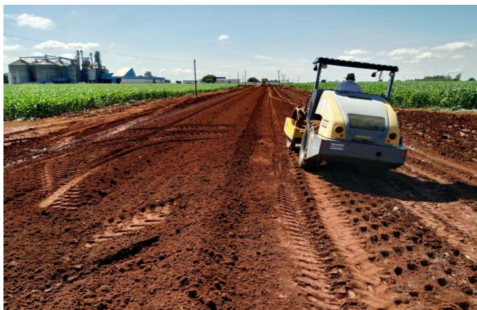
Figura 10 - Compactação com rolo da estrada
