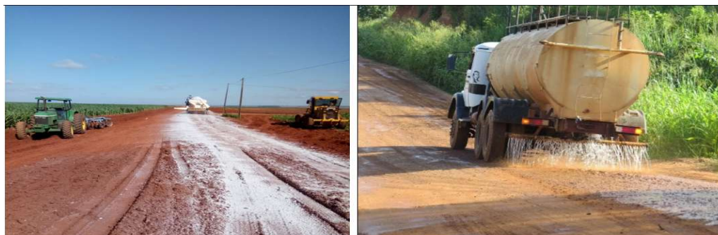
Figura 7 - Exemplo de distribuição/aplicação do estabilizando sólido e líquido
