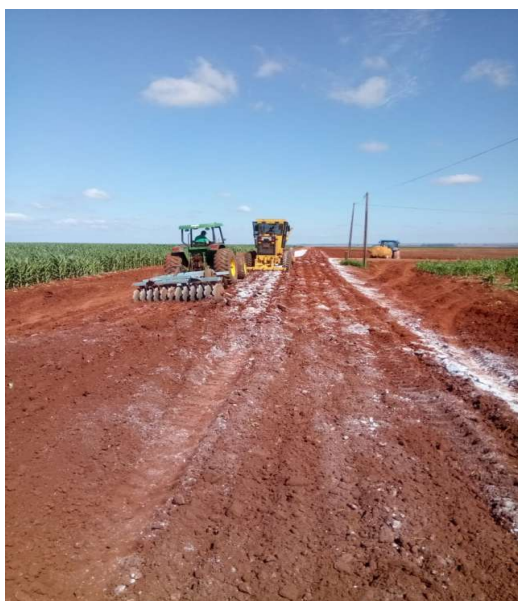
Figura 8 - Incorporação do produto na camada de 20 cm
