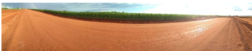
Figura 11 - Trecho finalizado após acabamento com motoniveladora e rolo.
